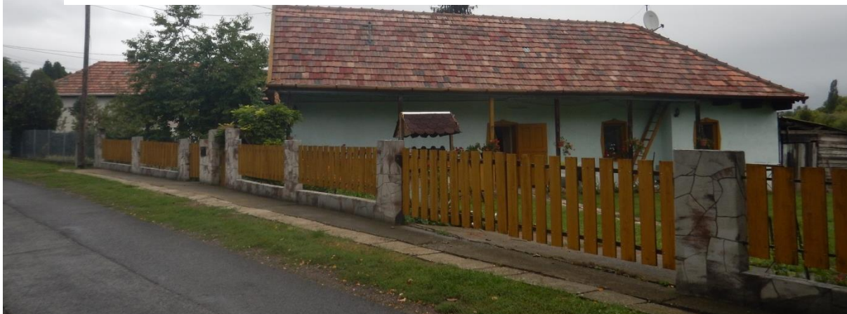
Rákóczi utcai népi lakóház: Az épület megőrizte a hagyományos parasztház tömegét, tetőformáját, anyaghasználatát, színvilágát. Az épület megőrizte kicsi ablakait, oromzati párkányát.
